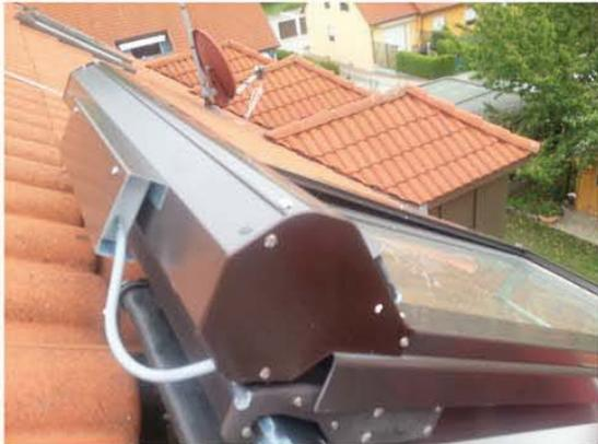
Nun muss nur noch der Akku aktiviert werden, dazu demontieren wir die Steuereinheit oben am Kasten. Durch lösen der oberen Schrauben kann die Einheit seitlich herausgezogen werden.
