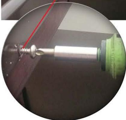
Nun mit den mitgelieferten Edelstahlschrauben durch die Bohrung den Rollladen Festschrauben.
