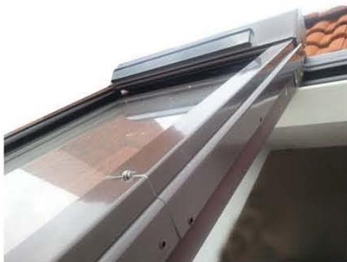
Das Fenster 2/3 zur Seite Schieben und den noch zusammen geklappten Rollladen durch die Öffnung oben aufs Dachfenster ablegen. Den Rollladen nun nach unten hin aufklappen und auf dem Fensterflügel ausrichten.
