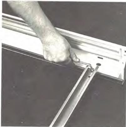
Profil **B4** als Montagehilfe für den genauen Zargenabstand zwischen den Seitenzargen **A1** und **A2** einsetzen (später als waagerechtes Laufschienen-Verbindungsprofil montieren).
