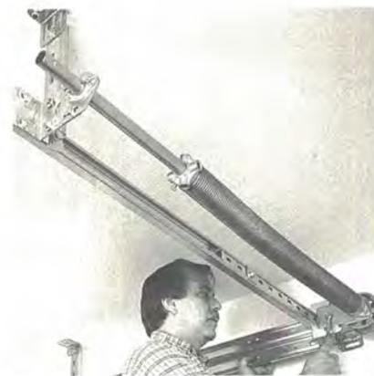
Die Torsionsfederwelle mu um **180°** gedreht werden.
