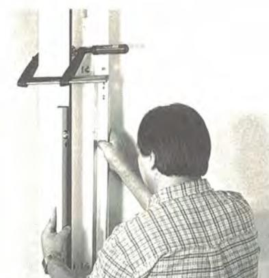
Die Seitenzargen **A1** und **A2** mit der Wasserwaage genau senkrecht ausrichten und die Rechtwinkligkeit durch Vergleich der diagonalen Abstände prüfen.
