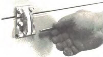
Die Torbandachsen vorsichtig mit dem Hammer in die Torband-Unterteile einschlagen, um die jeweiligen Sektionen zu verbinden. Den Zackenring am Achsenende aufstecken.
