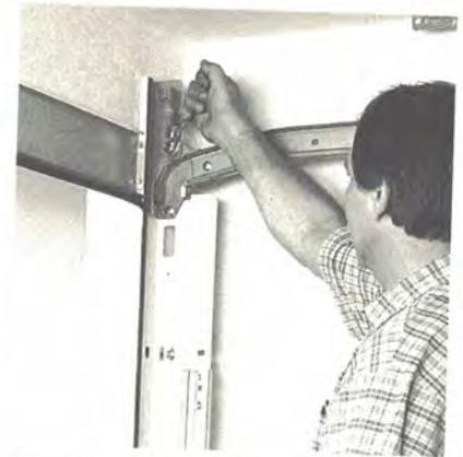
Die waagerechten Laufschiene **B1** und **B2** an den Kopfwinkel der Seitenzargen **A1** und **A2** mit Sechskantschrauben befestigen. Zuerst den Laufschienebogen montieren und diesen als Unterstützung verwenden.
