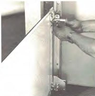
Bodensektion ① in den Zargenrahmen einsetzen. Laufrolle ② mit Laufrollenhalter in die linke und rechte Laufschiene einsetzen.
