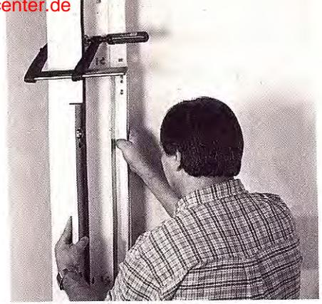
Die Seitenzargen ① und ② mit der Wasserwaage genau senkrecht ausrichten und die Rechtwinkligkeit durch Vergleich der diagonalen Abstände prüfen.
