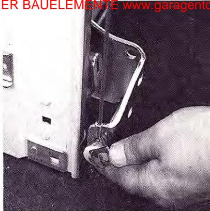
Metallschleife des Drahtseils auf den Bolzen der unteren Seilbefestigung ⑬ aufschieben und mit Unterlegscheibe und Klemmclips befestigen.
