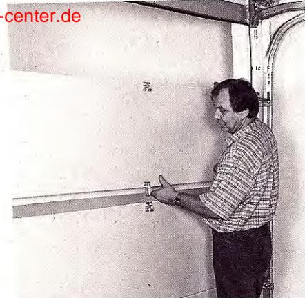
Mittelsektion ① auf die Schloßsektion aufsetzen.
