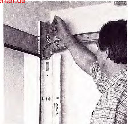
Die waagerechten Laufschienenpaare (B1) und (B2) an den Kopfwinkeln der Seitenzargen (A1) und (A2) mit Sechskantschrauben befestigen. Zuerst den Laufschienenbogen montieren und diesen als Unterstützung verwenden.
