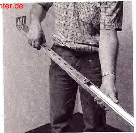
**D** Laufschienenbögen <sup>(B3)</sup> zwischen senkrechter und waagerechter Laufschiene <sup>(B1)</sup> und <sup>(B2)</sup> anschrauben.
