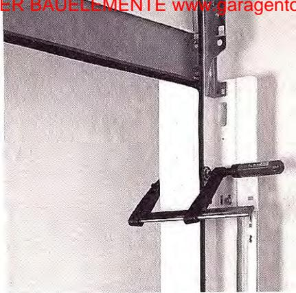
Zargenrahmen mit Schraubzwingen an der Wand fixieren.
