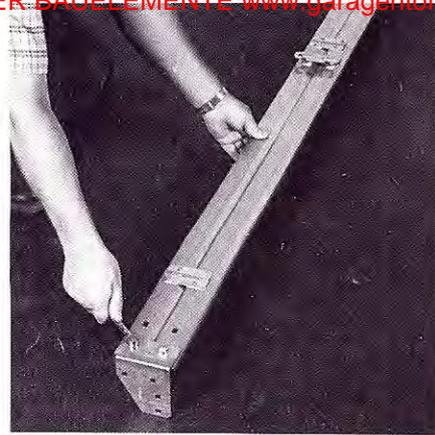
Formendstück (B8) Abhängungswinkel und Eckverbindungswinkel (B7) an den waagerechten Laufschienen (B1) und (B2) montieren.
