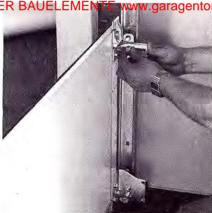
Bodensektion ⑩ in den Zargenrahmen einsetzen. Laufrolle ⑬ mit Laufrollenhalter in die linke und rechte Laufschiene einsetzen.
