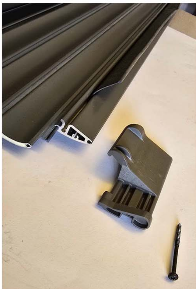
Endkappe abziehen jetzt kann die Endschiene zur gegenüberliegenden Seite herausgeschoben werden!
