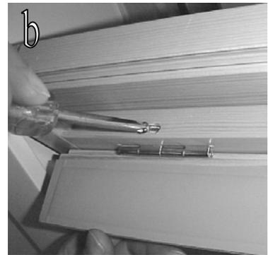
5. Ziehen Sie die Scharniere der Dauerlüftungs-klappe vorsichtig aus dem Flügeloberteil heraus.
