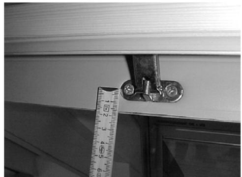
4. Nun können Sie die Schrauben herausdrehen, die den Schließarm (a) und die Scharniere (b) oben am Flügel festhalten.
