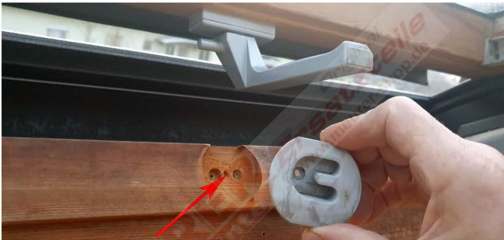
Altes Schließgegenstück durch lösen der Schraube demontieren
