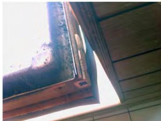
soweit wie möglich in dieser Flügelstellung, die Dichtung auch um die Ecken einarbeiten
