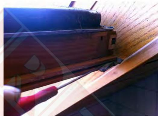
mit geeignetem Werkzeug (hier ein kleiner Schlitz-Schraubendreher), die alte defekte Dichtung aus der oberen Fenster-Nut entfernen
