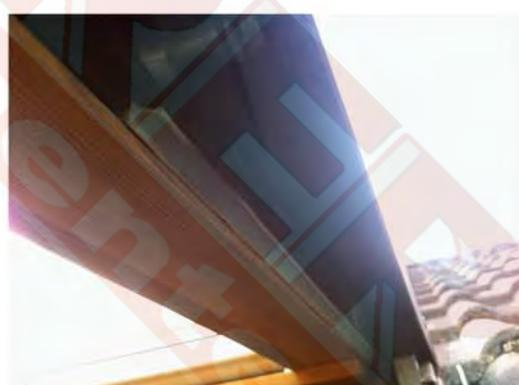
Dann bringen wir den Fensterflügel wieder in die Klappstellung und arbeiten die Dichtung nach unten weiter bis zum Stoß an die untere Schwarze Dichtung ein
