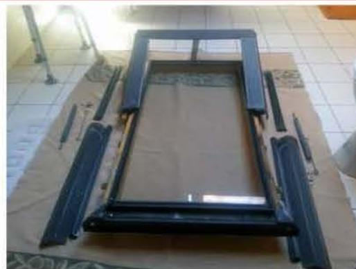
**Bleche von oben angefangen abnehmen. Die Bleche in der gleichen Position um das Fenster herum ablegen (erleichtert die spätere Montage)**
