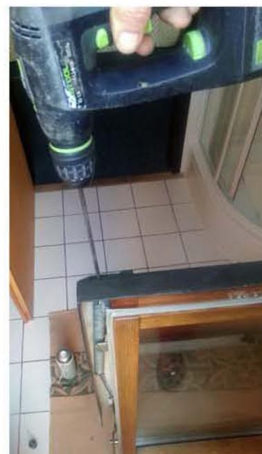
**Federn mit Imbusschlüssel wieder durch das Loch im oberen Abdeckblech auf den zuvor notierten Wert Spannen.**
