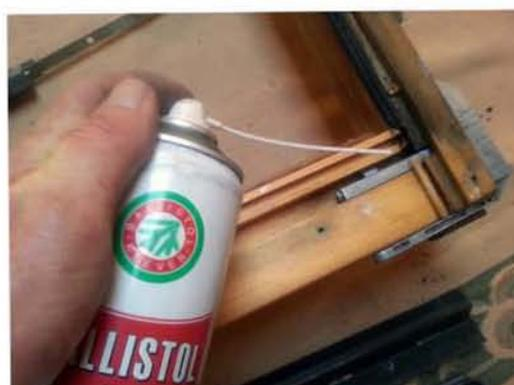
**Sämtliche Teile vor dem zusammenbau gründlich mit einem Sprühöl (WD-40 oder Ballistol, etc.) schmieren. Alles was sich am Fenster bewegt schmieren, so ist das Fenster nachher wieder leichtgängig zu bedienen.**
