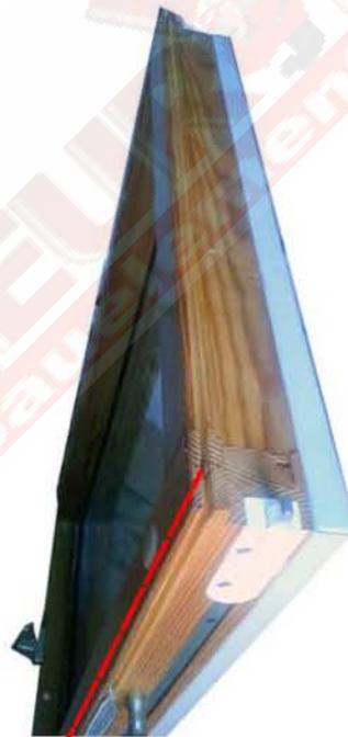
Alte Dichtung mit dünnem Schraubendreher aus der Nut entfernen
