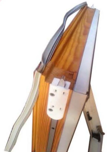
Mit der Neuen Dichtung an den Ecken Anfängen und dann in die Nut eindrücken!
