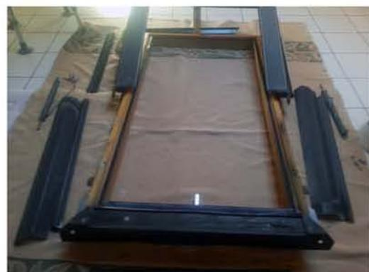
**und die untere Dichtung wieder über das untere Blech in die Nut drücken**
