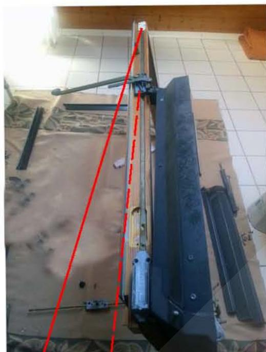
**Fensterflügel nun seitlich hinstellen und das Mittellager sowie den oberen Schnapper lösen**
