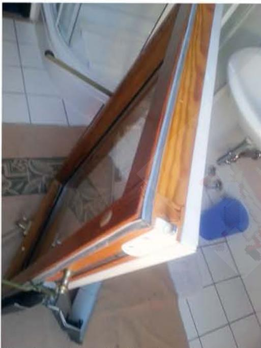
Vor dem Einbau im Fensterrahmen kann jetzt noch die evtl. im Laufe der Jahre (Spröde bzw. brüchig) gewordene obere Graue Dichtung erneuert werden
