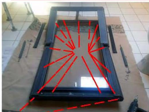
**Abdeckkappen entfernen, Markierung der Federspannung notieren. Die Federn mit Imbus-schlüssel entspannen und mit dem Gestänge aushängen. Sämtliche sichtbaren Schrauben der Abdeckbleche lösen.**
