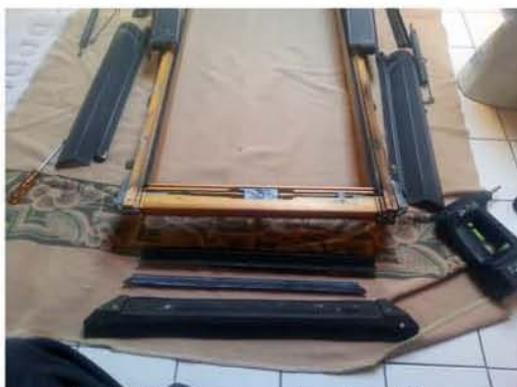
**Jetzt liegt die Mechanik frei und kann nach lösen der Befestigungsschrauben demontiert werden**
