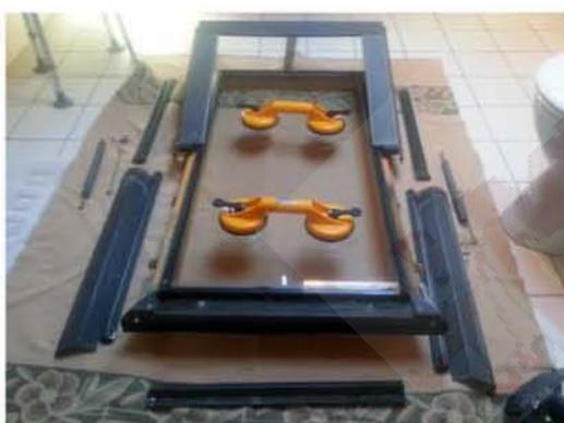
**jetzt kann die Glasscheibe angehoben und nach unten herausgezogen werden. Sollte diese noch an den Dichtungen festkleben, so ist dies durch Ruckeln der Scheibe zu lösen.**
