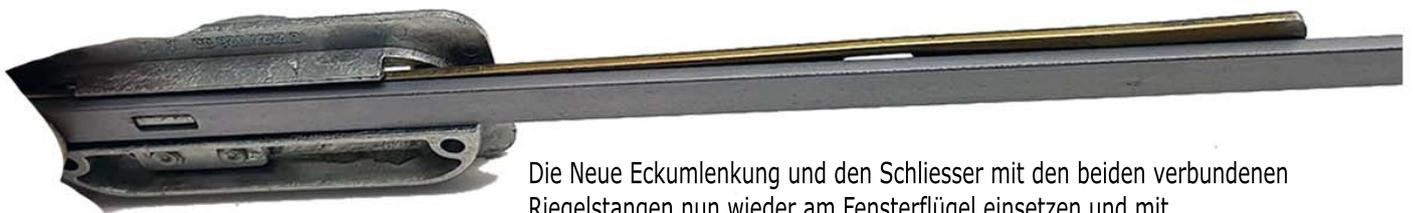
Die Neue Eckumlenkung und den Schliesser mit den beiden verbundenen Riegelstangen nun wieder am Fensterflügel einsetzen und mit Schrauben befestigen!
