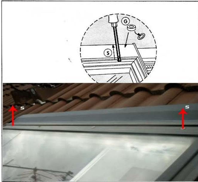
Abb. 2: Schrauben am Glasrahmen herausdrehen
